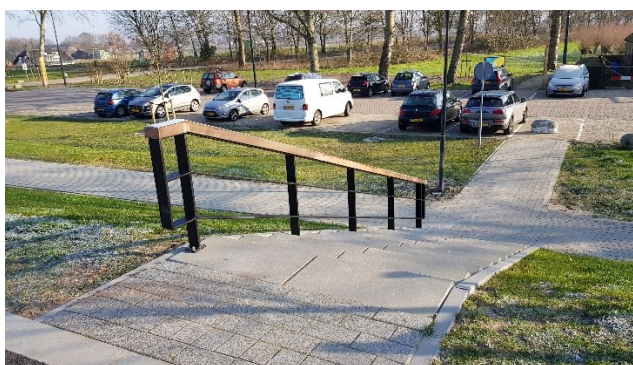
Trap tussen promenade en parkeerterrein haven
