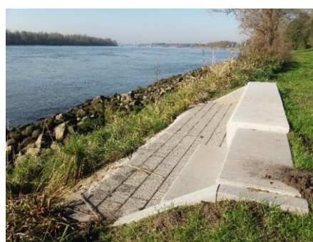
Betonnen zitranden in de stortranden langs de Oude Maas
